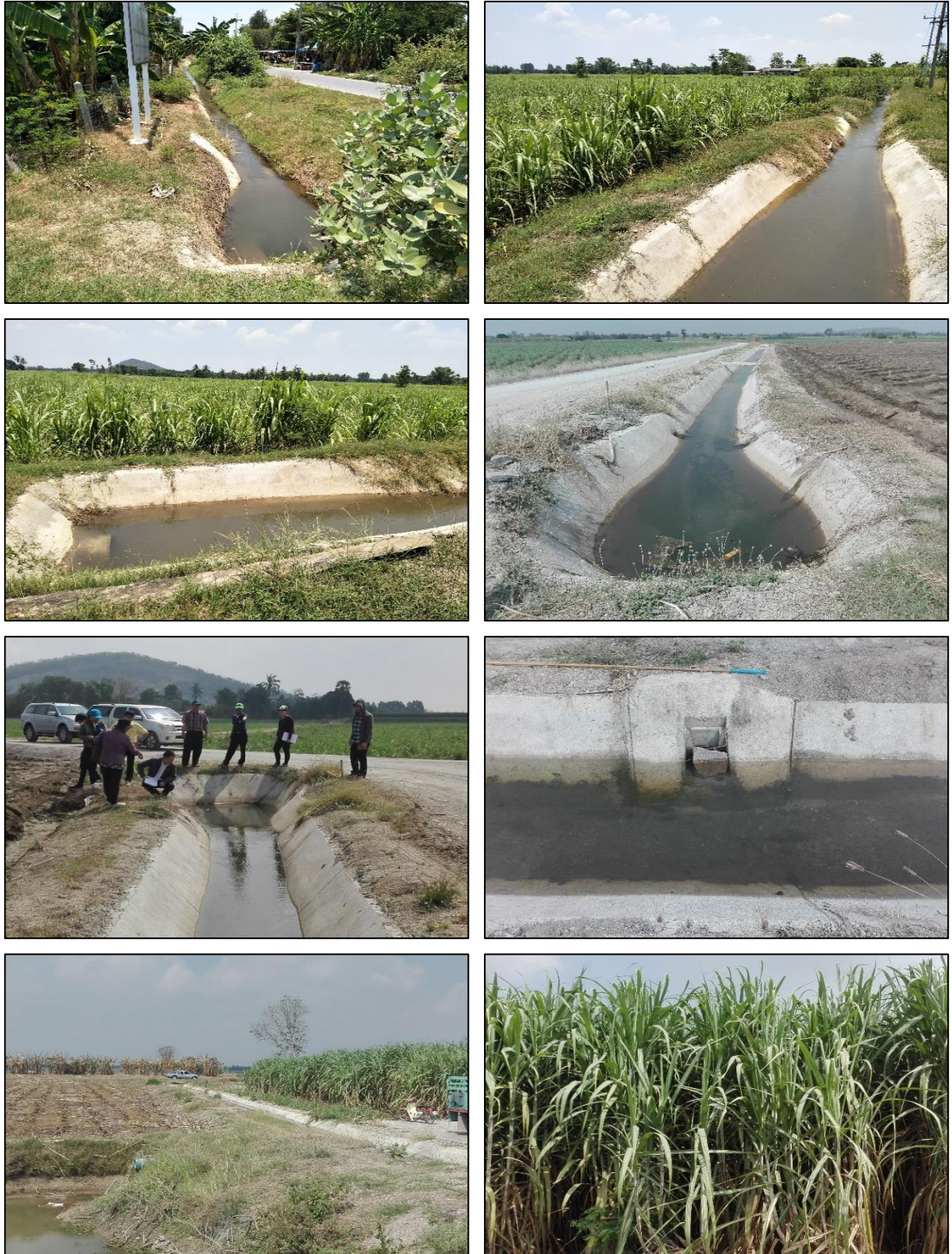
ภาพที่ 3.3 งานจัดระบบน้ำ โครงการส่งน้ำและบำรุงรักษาสองพี่น้อง คลอง 4 ซ้าย - 5 ซ้าย - 2 ซ้าย จังหวัดสุพรรณบุรี
