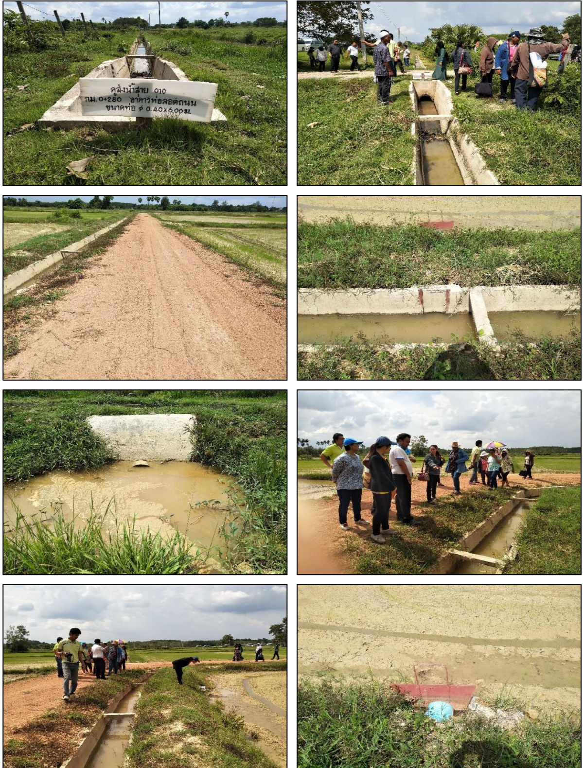
ภาพที่ 3.6 งานจัดระบบน้ำ โครงการฝายบ้านพร้าว ระยะที่ 1 คลอง LMC จังหวัดพัทลุง ที่มา : จากการสำรวจ, 2561
